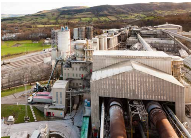
Bild 4: Ansicht eines Zementwerks in Großbritannien mit einer neuen Annahmestation für PSP
