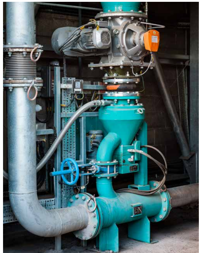
Bild 3: MULTICOR® Massendurchfluss-Messgerät von Schenck Process für PSP
