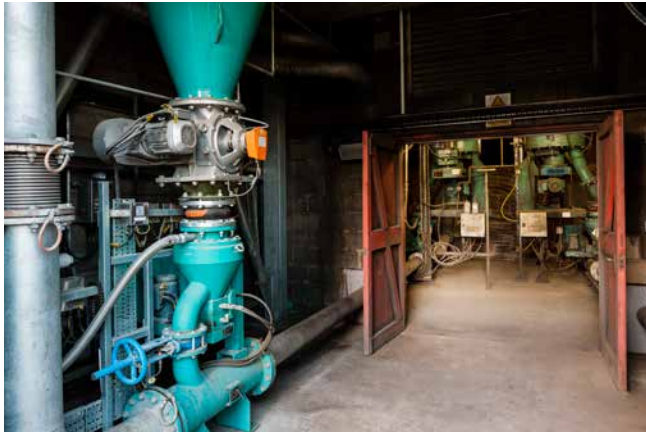
Bild 2: MULTICOR® Massendurchfluss-Messgerät für PSP, der das Material in die gleiche Rohrleitung dosiert wie die vorhandenen Kohlenstaubdosierer
